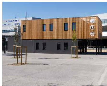
12_ Pôle d'échanges de l'aéroport Toulouse Blagnac / Blagnac (31) / Pierrard Architecte Crédit photo : Nico Froment / Atelier Cart Blanch
