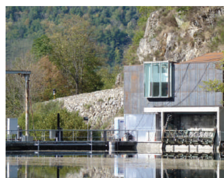
6_ Local de commande EDF au barrage de Campauleil / Orgeix (09) / Olivier Sanchez
