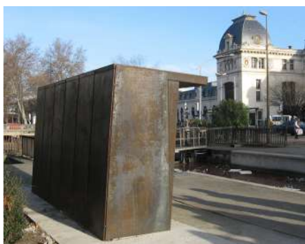
1_ Cabines de commande d'écluses / Toulouse (31) / Joseph Almudever Crédit photo : Agence A.F.A
