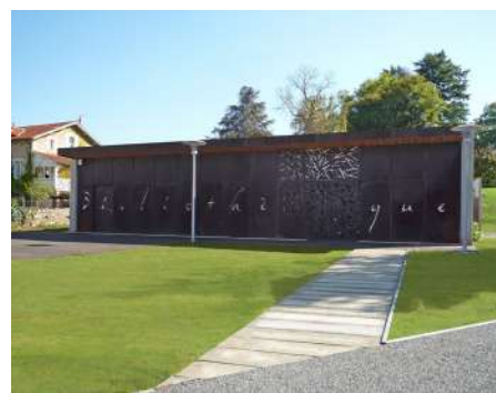
3_ Construction d'une bibliothèque / Capdenac (46) / Philippe Bergès Crédit photo : Philippe Bergès Architecte
