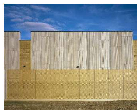
15_ Poste du Palayre / Toulouse (31) / Architecture Malacan-Martres Crédit photo : Cadrage
