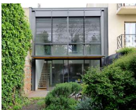
13_ Rénovation et extension d'une maison individuelle/ Toulouse (31) / Stéphane Deligny Crédit photo : Stéphane Deligny
