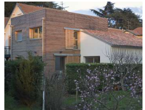
18_ Réhabilitation et extension d'une maison de ville / Toulouse (31) / Daniel Ponchet
