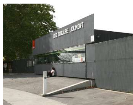
12_ Loge du concierge du lycée de Jolimont / Toulouse (31) / Laurens et Loustau architectes Crédit photo : Laurens et Loustau architectes
