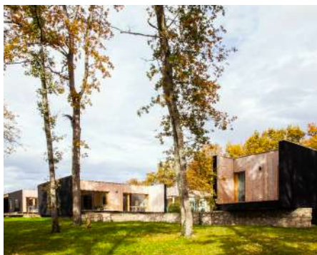
7_ Maison HM1 / Aurignac (31) / Prax Architectes Crédit photo : Mathieu Lolagne
