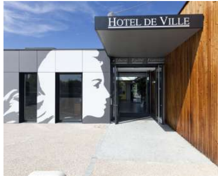
14_ Réhabilitation et extension d'une mairie / Fonbeauzard (31) / Lexa Conception Crédit photo : Jacques Splerpinski
