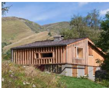
2_ Chalet K1 / Garin (31) / Prax Architectes Crédit photo: Mathieu Lolagne
