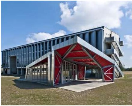
13_ Extension et restructuration du foyer LEPA / Saint Gaudens (31) / Christian Lefebvre avec Joseph Almudever Crédit photo : Christian Lefebvre
