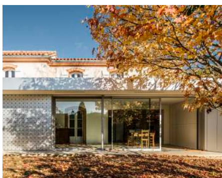
5_ Extension d'une maison individuelle / L'Union (31) / V2S Architectes Crédit photo : Sylvain Mille
