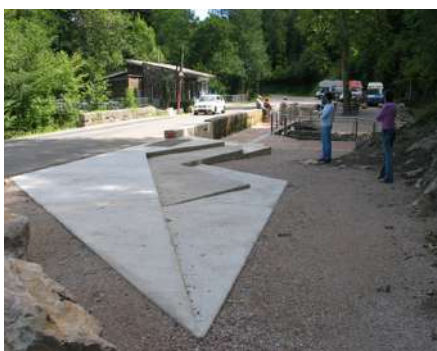
8_ Aménagement du site de la fontaine de Fontestorbes / Bélesta (09) / Architecture et Paysage Crédit photo : Marc Mesplé + A&P
