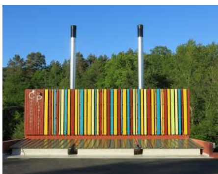
4_ Chaufferie du Plantaurel / Monéigut-Plantaurel (09) / Architecture et paysage Crédit photo : Dumons Barthélémy
