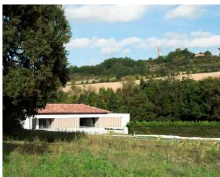
16_ Réhabilitation et extension de la mairie de Bertre / Bertre (81) / ATP Architecture Territoire Paysages
